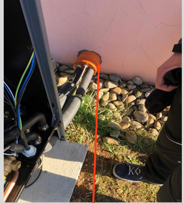
Wanddurchführung spaltfrei verbaut
